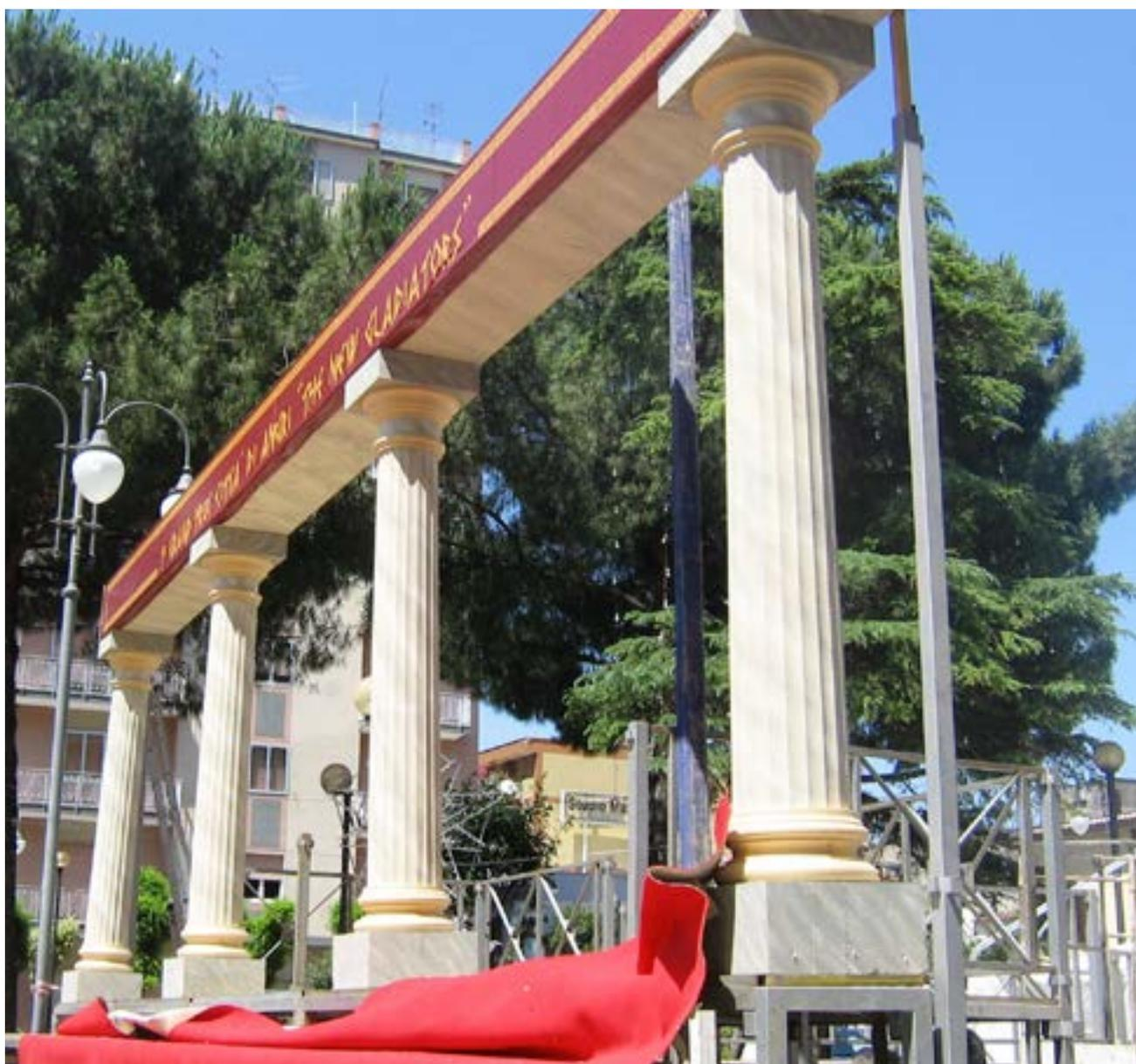
Le **Colonne** sono realizzati in EPS (150) Polistirolo espanso rivestiti da una resina cementizia fibro-rinforzata per esterno ed ottenere maggiore resistenza agli agenti atmosferici e idonea alla successiva tinteggiatura.
