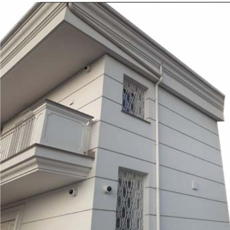
**Le Pannellature per rivestimenti** sono realizzati in EPS (150) Polistirolo espanso rivestiti da una resina cementizia fibro-rinforzata per esterno ed ottenere maggiore resistenza agli agenti atmosferici e idonea alla successiva tinteggiatura.
