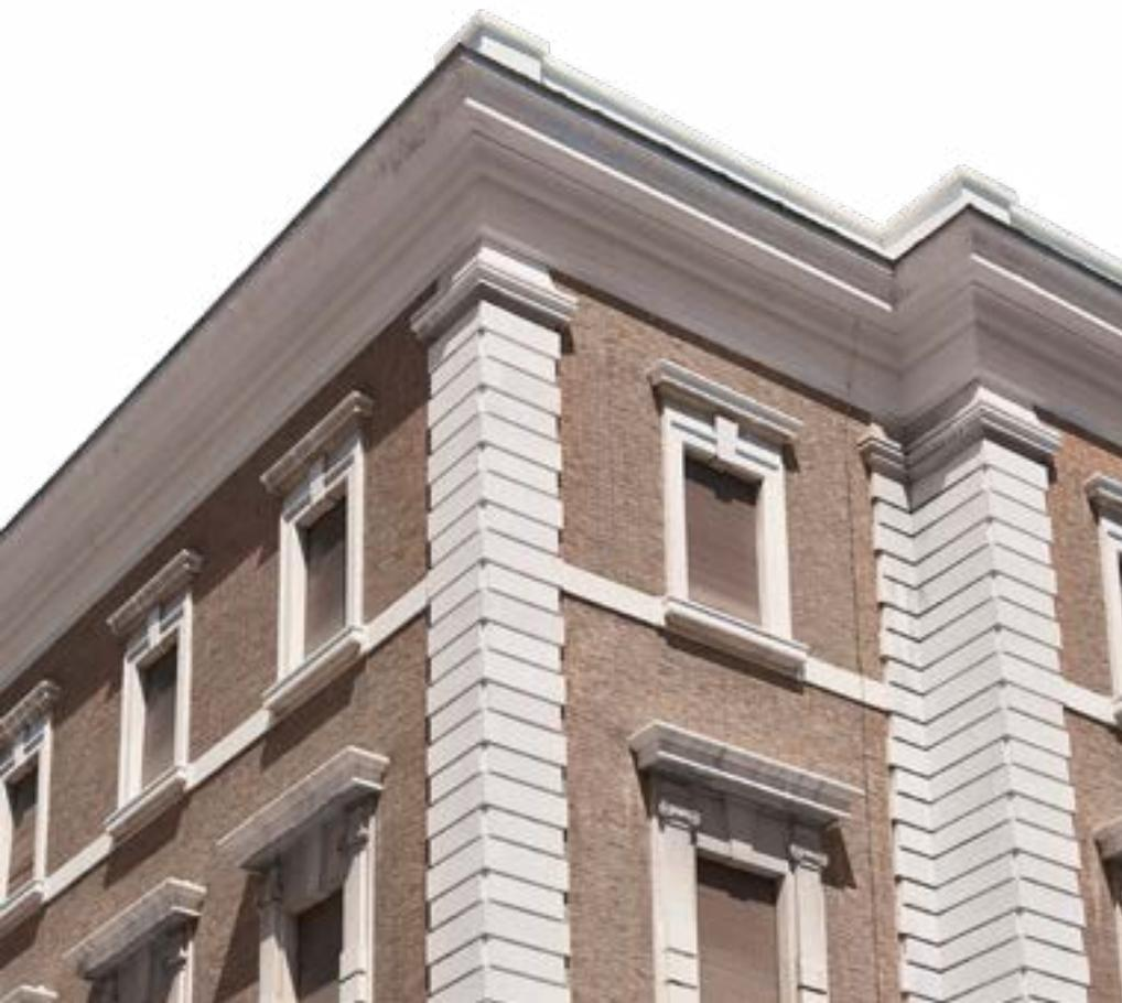
I **Cornicioni o cornici di sottogronda** sono realizzati in EPS (150) Polistirolo espanso rivestiti da una resina cementizia fibro-rinforzata per esterno ed ottenere maggiore resistenza agli agenti atmosferici e idonea alla successiva tinteggiatura.
