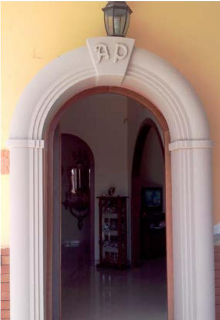
Le **Chiavi di volta** e d'arco sono realizzati in EPS (150) Polistirolo espanso rivestiti da una resina cementizia fibro-rinforzata per esterno ed ottenere maggiore resistenza agli agenti atmosferici e idonea alla successiva tinteggiatura.
