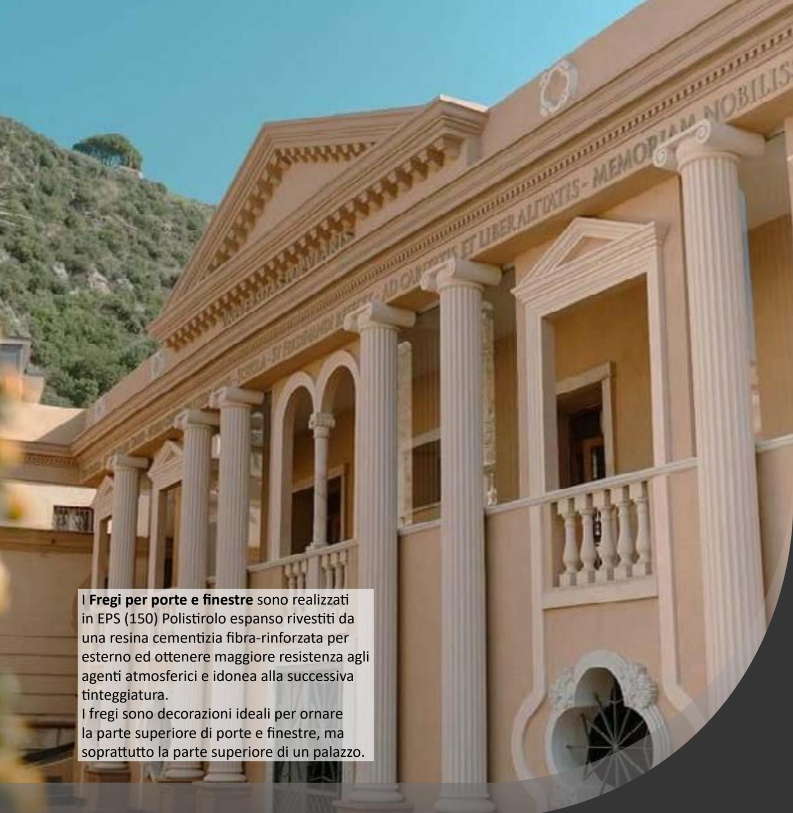
I **Fregi per porte e finestre** sono realizzati in EPS (150) Polistirolo espanso rivestiti da una resina cementizia fibra-rinforzata per esterno ed ottenere maggiore resistenza agli agenti atmosferici e idonea alla successiva tinteggiatura.
